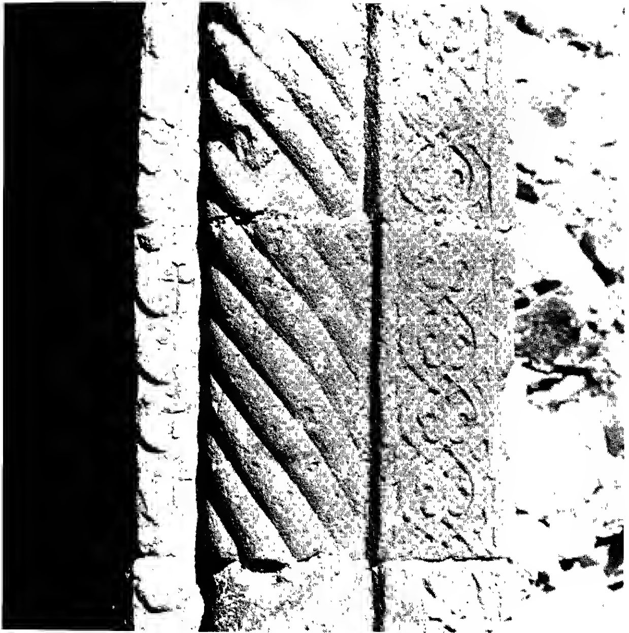
FIG. 15. — Adilcevaz-Altziké : détail du porche.
